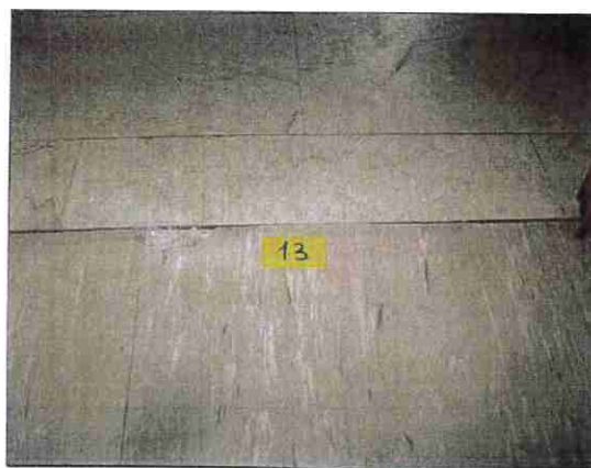
Foto 10: C.13 - AMIANTO ASSENTE
