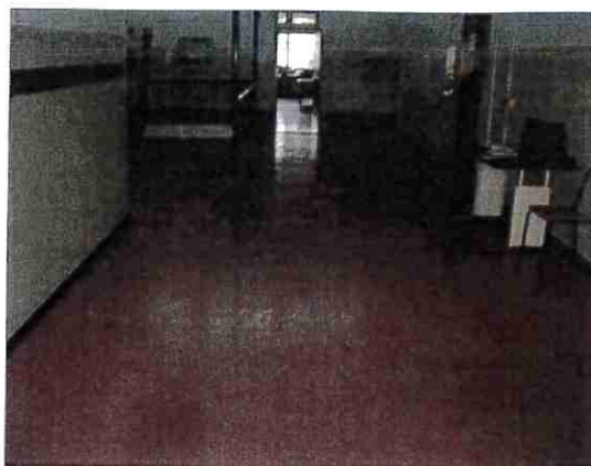
Foto 9: C.12 - AMIANTO ASSENTE
