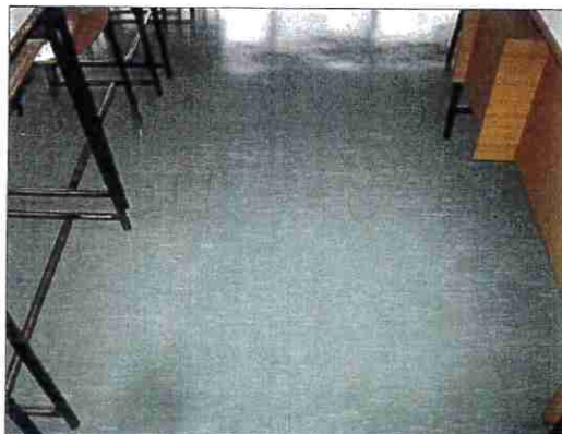
Foto 6: C.9 - AMIANTO ASSENTE
